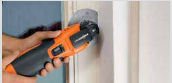
Metallisten kiinnitysvanteiden katkaisemiseen vanhoja ikkunoita irrotettaessa.
