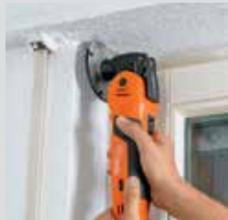
Ulkopuolisten kaihdinlaitteistojen suojusten purkamiseen.
