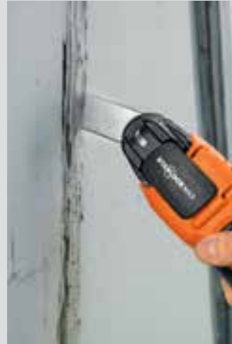
Elastisten saumatiivistysaineiden poistamiseen maanpinnan ylä- ja alapuolisista rakenteista.
